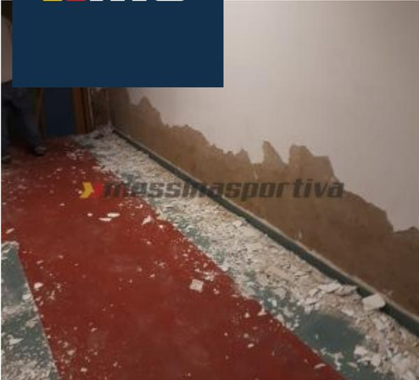
Un muro trattato per eliminare umidità e danneggiamenti
